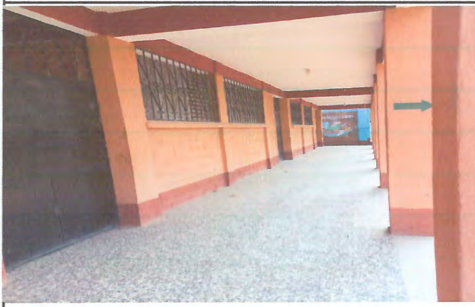
Foto 4: Pintura general del establecimiento
