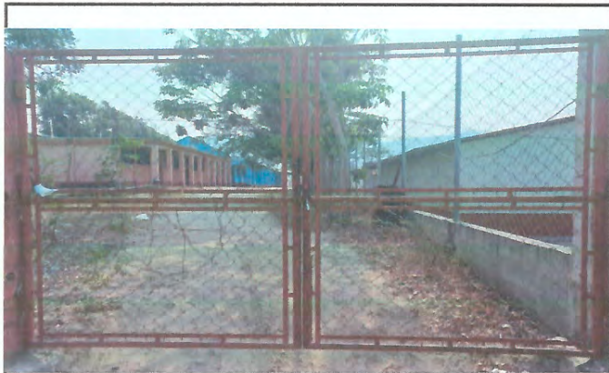
Foto 1: Mejoramiento a portón de ingreso
