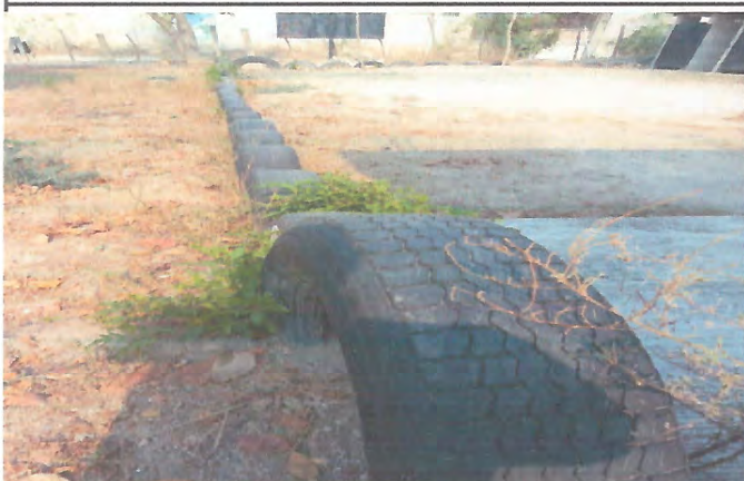
Foto 3: Mejoramiento muro de contención
