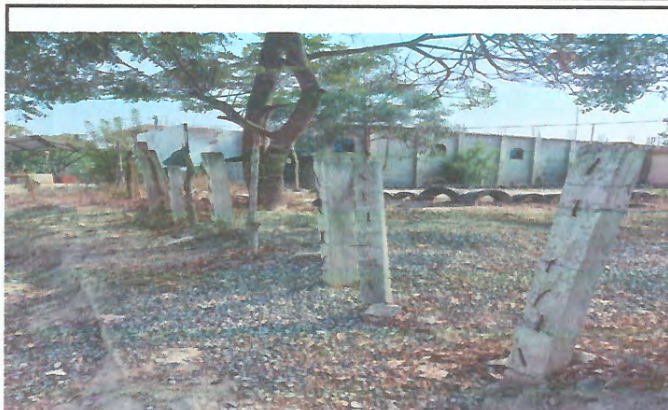
Foto 2: mejoramiento a muro perimetral
